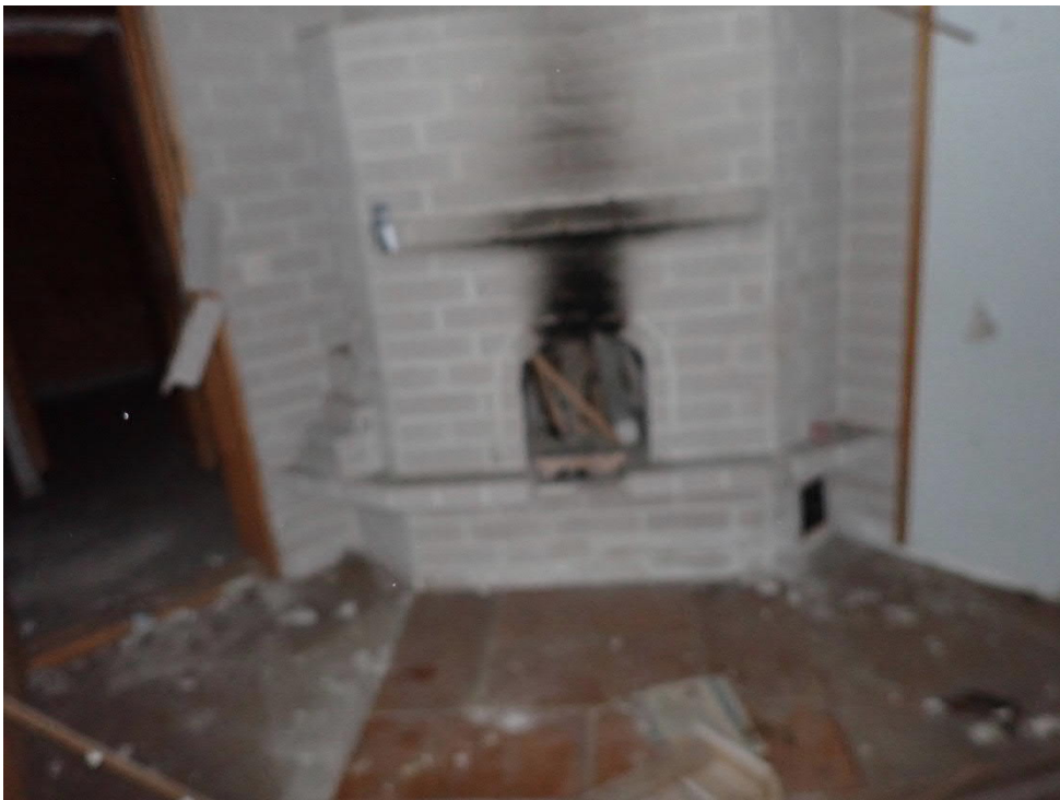
Kuva 14. Kellarin takan edustalla olevan lattialaatoituksen laasteista kerätyssä näytteessä (ASB16) ei havaittu asbestia.
