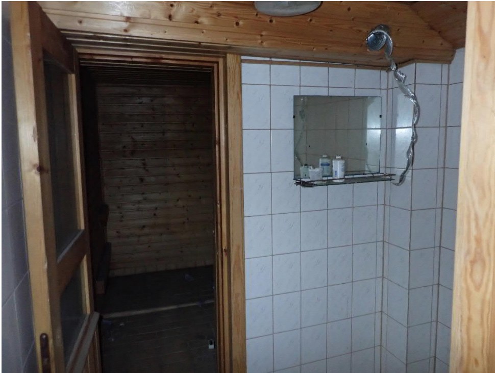
Kuva 13. Pesutilojen laatoitusten laastit eivät sisällä asbestia. Näyte ASB15 pesuhuone 1 lattialaatoituksesta.
