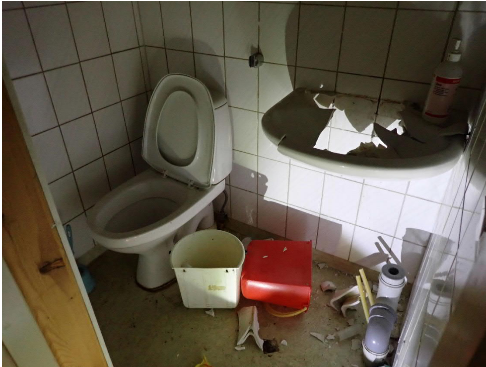
Kuva 11. WC 2 lattiassa kaksi muovimattoa ja tasoite. Kokoomanäytteessä (ASB12) ei havaittu asbestia.
