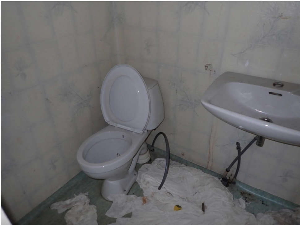
Kuva 8. WC:n 1 seinien muovitapetit (näyte ASB7) ja lattian muovimatto (näyte ASB8) eivät sisällä asbestia.
