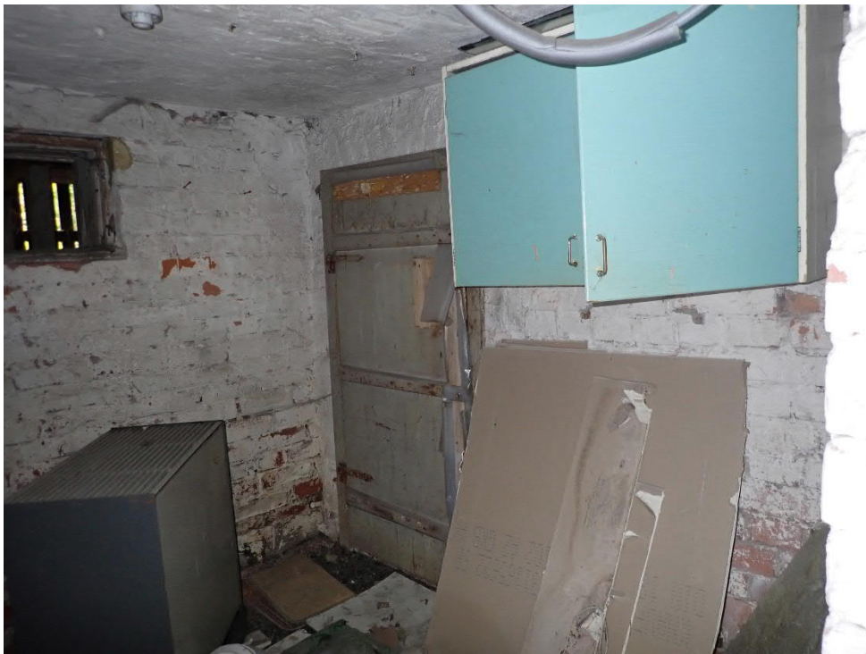
Kuva 12. Kellaritilojen seinien ja katon rappaus eivät sisällä asbestia (näytteet ASB13 ja ASB14).
