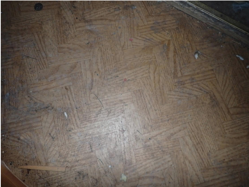
Kuva 7. Puukuviainen muovimatto ei sisällä asbestia (näyte ASB6). Kuva eteisestä 1.
