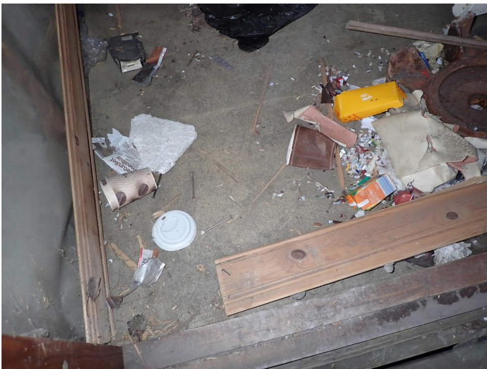
Kuva 6. Kuistin 1 harmaa muovimatto ei sisällä asbestia (näyte ASB5).
