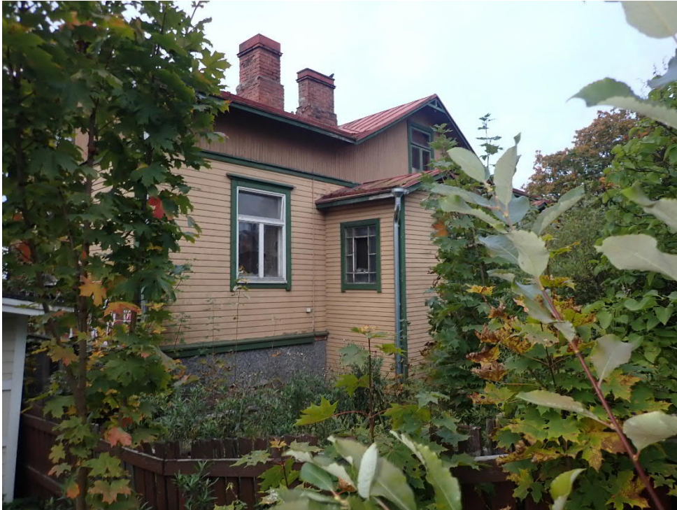
Kuva 5. Rakennuksen ulkopuoliset pinnoitteet tai kitit eivät sisällä asbestia (näytteet ASB1, ASB2, ASB3).
