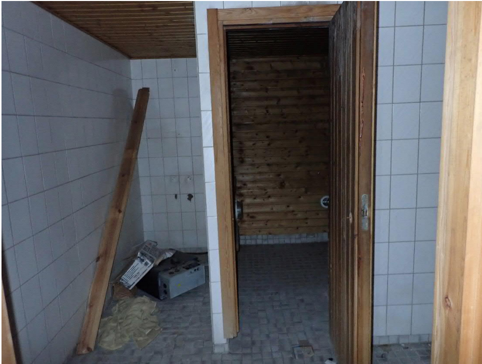
Kuva 15. Pesutilojen laatoitusten laastit eivät sisällä asbestia. Näyte ASB17 pesuhuone 2 lattialaatoituksesta ja näytteet ASB18 / ASB19 seinälaatoituksista.
