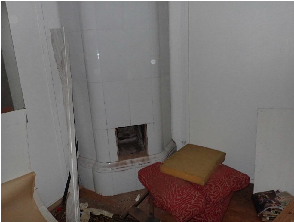
Kuva 9. Tulipesien tiilet ja laastit tai hormien rappaukset eivät sisällä asbestia (näytteet ASB4, ASB9 ja ASB10). Kuva makuuhuoneesta 1.
